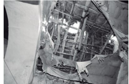
Detalle de la Sujeción de la Estructura de Madera.
