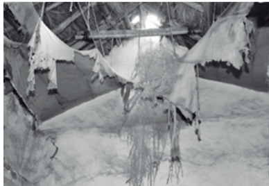
Detalle de Estructura de la Cubierta - Transepto.
