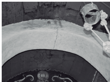
Grietas y Fisuras al Interior de la Cubierta.
