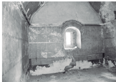
Deformaciones en los Muros Interiores por Humedad.
