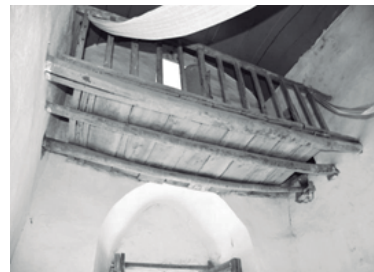
Coro cuya estructura de carrizo presenta fragilidad y resequedad.
