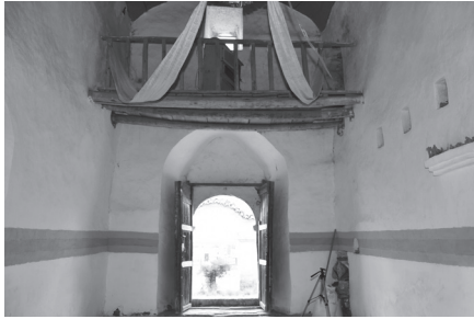
Vista del Vano de Acceso.
