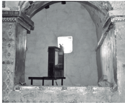
Espacio Abovedado anexo al Camarín.
