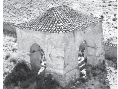
Vista Sud - Oeste de la Capilla Miserere.
