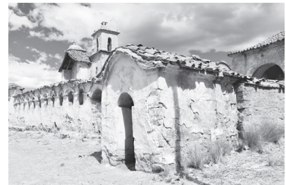
Vista sur-este Capilla Posa
