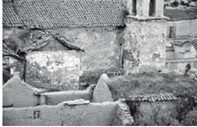
Deformaciones en los Muros Interiores por Humedad.
