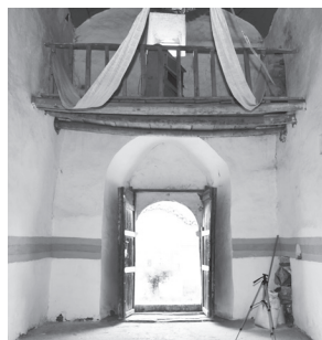
Vista del Ingreso Principal y del Coro.
