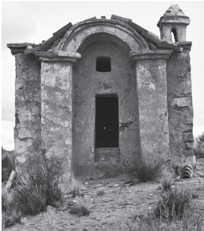
Vista frontal de la Capilla Perimetral.
