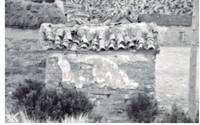
Daño en los Muros.
