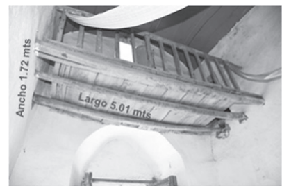
Estructura base Tronco Rollizo.
