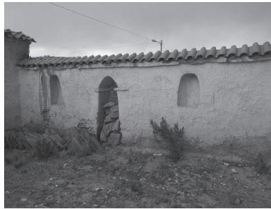
Muro Lateral Izquierdo.
