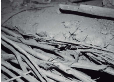
Detalle de la estructura de Piso, tipo entortado de barro sobre caña hueca.
