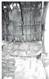
Hundimiento del Cielo Falso, con desprendimiento de revoque interior.
