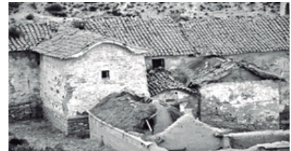
Daño en las Cubiertas de la Hospedería.
