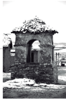
Capilla Calvario Vista Sud - Este.
