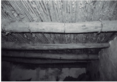
Detalle de la estructura del pequeño coro a lado del Camarín.
