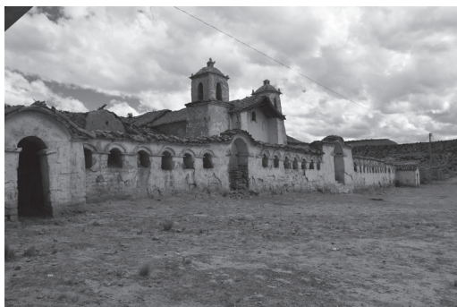
Vista del Muro Atrial.
