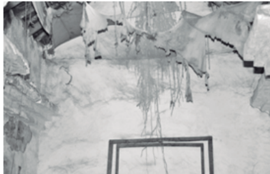
Hundimiento de la teja española en la cubierta altar menor lateral fragilidad capilar por humedad, despigmentación
