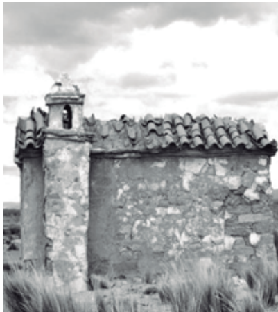
Vista lateral derecha de la Capilla Perimetral.
