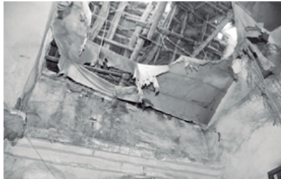
Hundimiento de la teja española en la cubierta altar menor lateral izquierdo Desprendimiento tela protectora (cielo falso).
