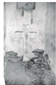
Hundimiento del Cielo Falso, con desprendimiento de revoque interior.
