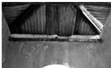
Estructura de madera.
