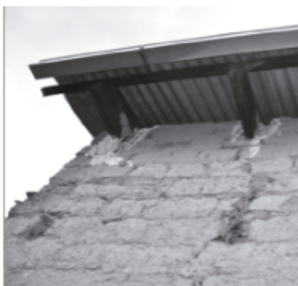
Insectos que anidan en la estructura de la cubierta y el deterioro del mismo.
