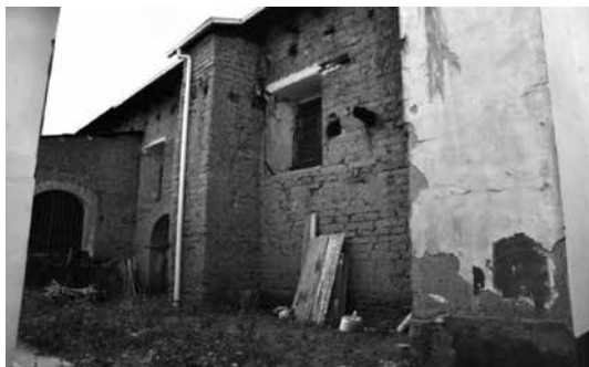
Muro Lateral Izquierdo.
