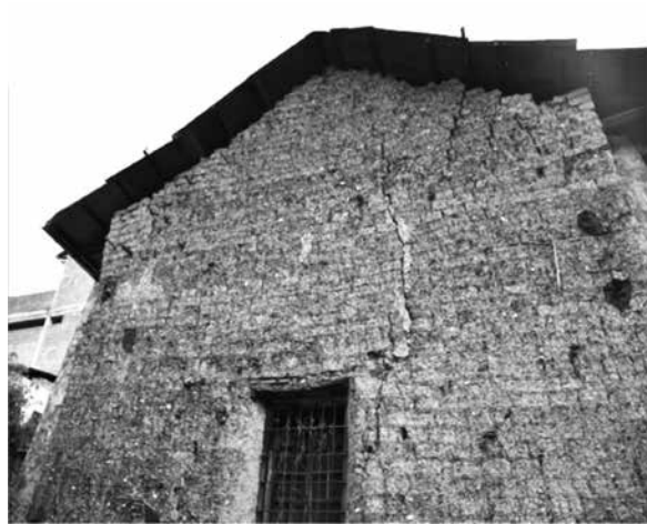
Fachada Posterior del Templo
