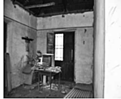
Vista primer piso.
