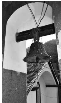
Vista int. Torre Campanario.
