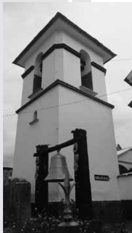
Vista Torre Campanario.
