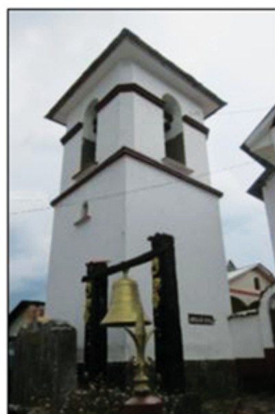
VISTA TORRE CAMPANARIO
