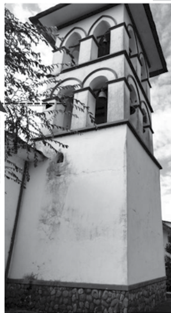
Vista lateral izquierda de la torre campanario.
