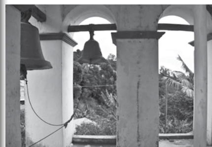
Vanos para la ubicacion de las campanas
