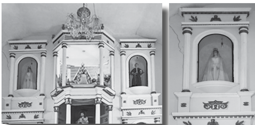
Fisuras en el muro del retablo
