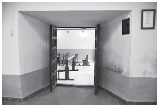
Baptisterio, vista hacia la nave.
