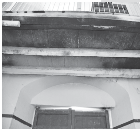
Ennegrecimiento y parcial deterioro de la estructura base de madera del coro
