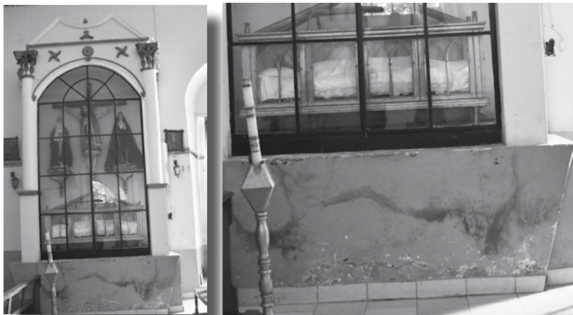
Desprendimiento del acabado de muros interiores de la nave, especialmente en los zócalos
