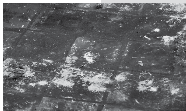
Deformaciones en el acabado de pisos, Eflorescencias y material vegetal, heces de lechuzas y otras aves
