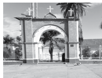
Portada del atrio del Templo de Chirca, presenta humedad por capilaridad en su zócalo
