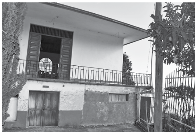
Pérdida de revestimiento por humedad
