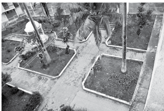
Revestimiento de piso cerámico dañado
