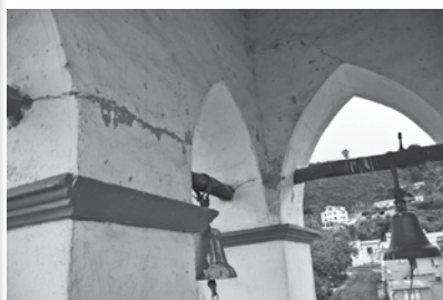
Detalle de los arcos ojival de los vanos.
