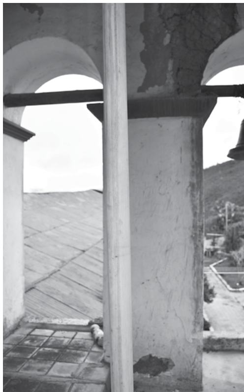
Deformaciones en el acabado de pisos, Eflorescencias y material vegetal, heces de lechuzas y otras aves
