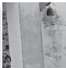
Pérdida del acabado exterior del muro de la portada
