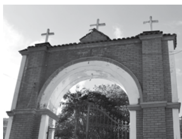
Se detecta humedad en su cubierta de teja española
