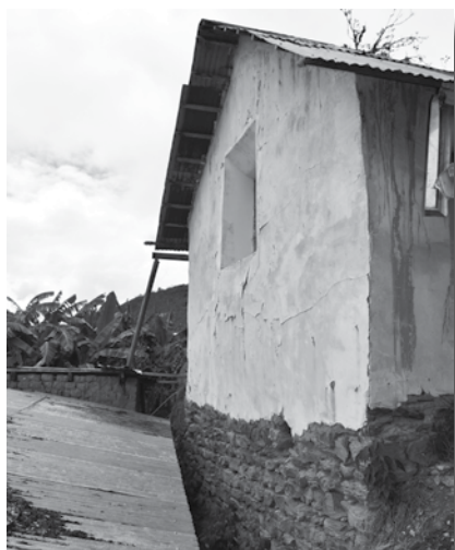
Pérdida del acabado exterior del muro de la portada, mayor afectación en el zócalo
