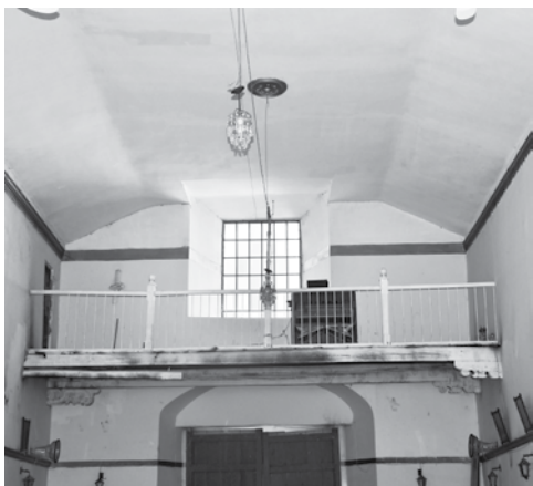
Ennegrecimiento y parcial deterioro de la estructura base de madera del coro
