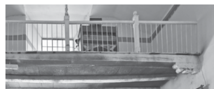
Vista estructura del coro.
