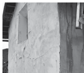
Pérdida del acabado exterior del muro de la portada
