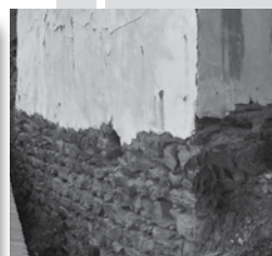
Deterioro en el zócalo
