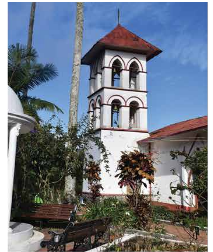
VISTA DE LA TORRE CAMPANARIO
