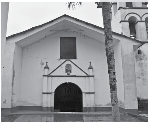
Pérdida del acabado exterior del muro de la portada, mayor afectación en el zócalo
