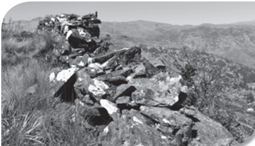
Fig. 17: Vista al muro 1 del área TW-1.
