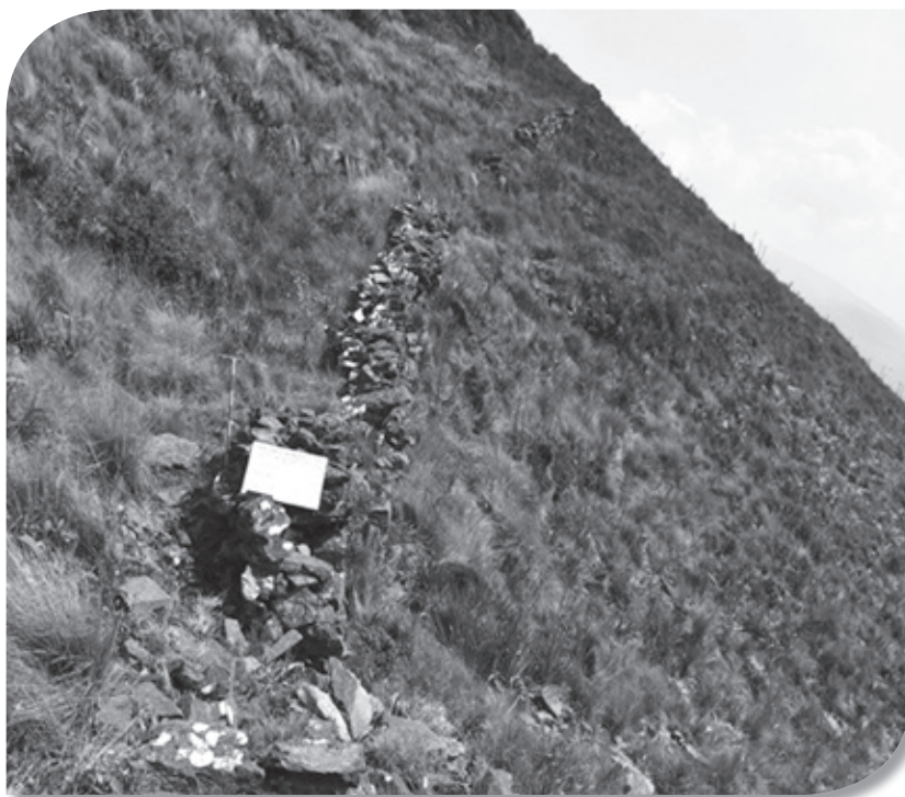
Fig. 5: Vista al Muro perimetral del sitio.
