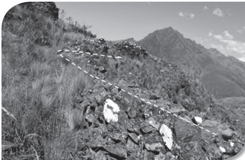
Fig. 18: Vista al muro 2 del área de TW-1.
